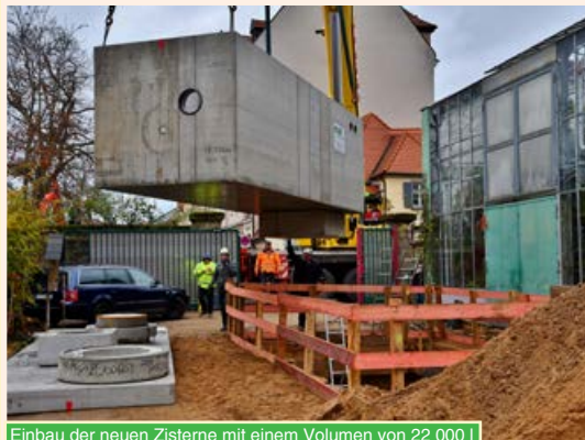
Einbau der neuen Zisterne mit einem Volumen von 22 000 l
