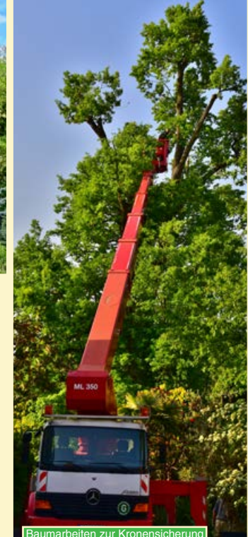
Baumarbeiten zur Kronensicherung
