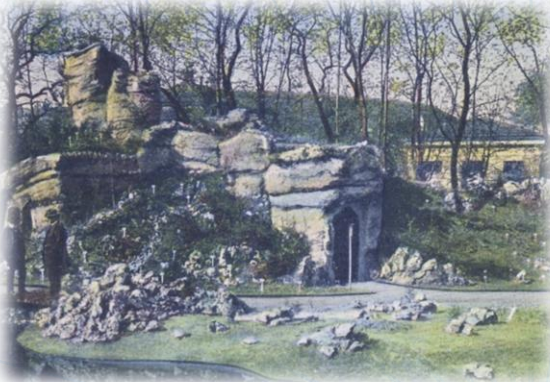
Zustand nach der Errichtung 1907
